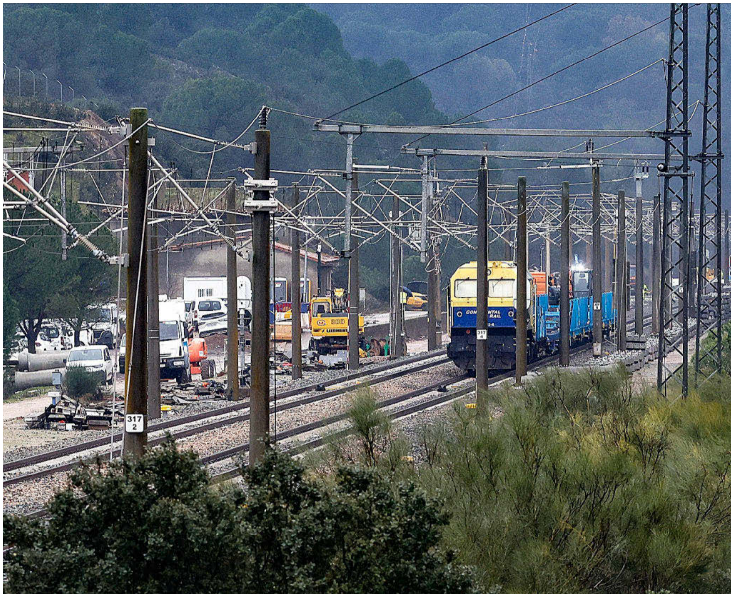
Operarios de Adif trabajan en el arreglo del tramo de ferrocarril donde ocurrió el accidente, en Adamuz. EUROPA PRESS
